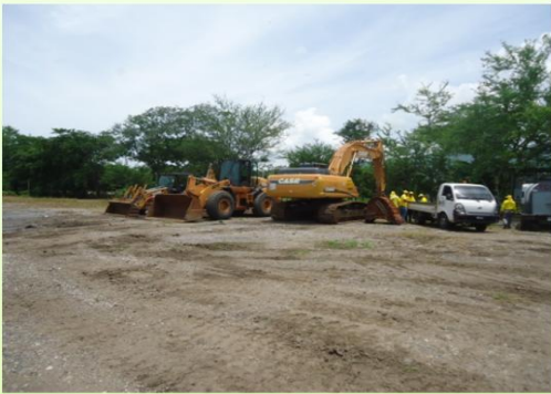
Maquinaria destinada al proyecto
