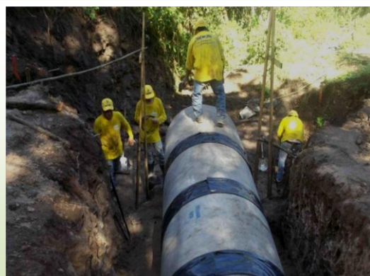
Colocación de tuberías de 42". (Foto de FUNDE)
