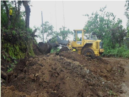
Excavaciones para la ampliación de la vía. (Foto de FUNDE)
