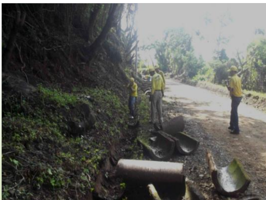
Remoción de canaletas existentes. (Foto de FUNDE)
