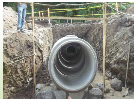
Colocación de tuberías de 42". (Foto de FUNDE)
