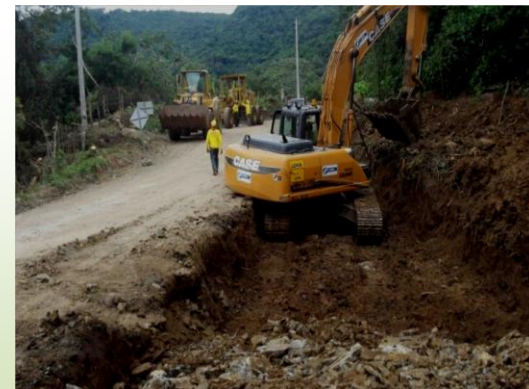
Preparación del terraplén en la vía. (Foto de FUNDE)
