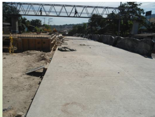
Vista panorámica de la obra (Foto de Funde)
