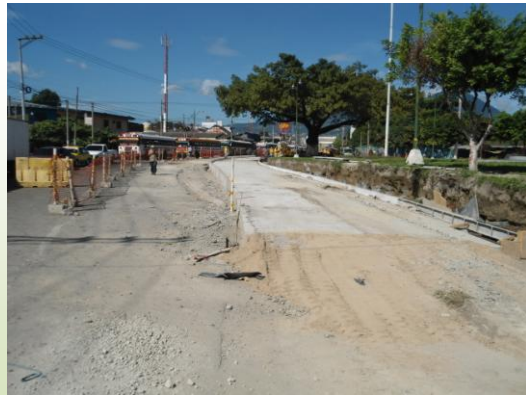
Bases para las parada de buses (Foto de Funde)
