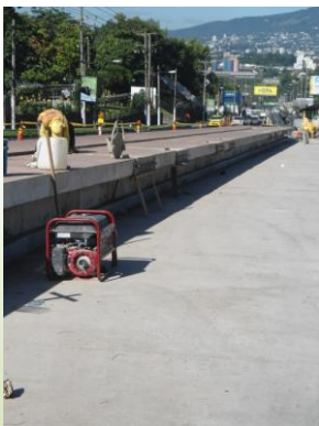
Vista Panorámica de la obra (Foto de Funde)
