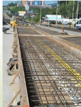
Emplantillado plataforma paradas de buses (Foto de Funde)
