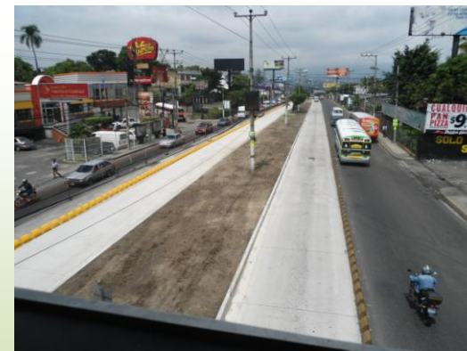
Vista panorámica del corredor segregado. Primer tramo. (Foto de FUNDE)
