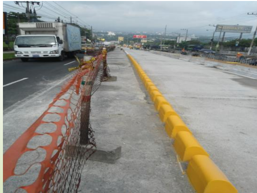
Separadores para el carril segregado. (Foto de FUNDE)
