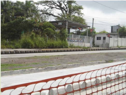
Separadores y vallas de protección. (Foto de FUNDE)
