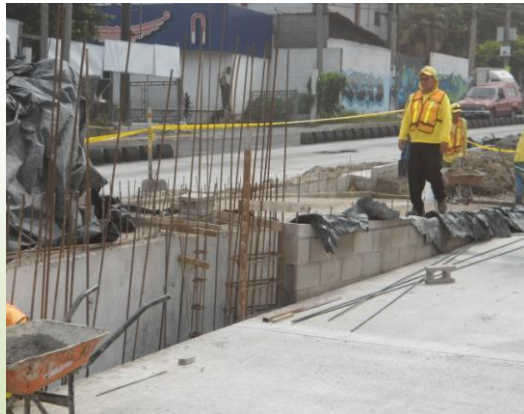
Fundación para la parada de buses Amatepec. (Foto de FUNDE)
