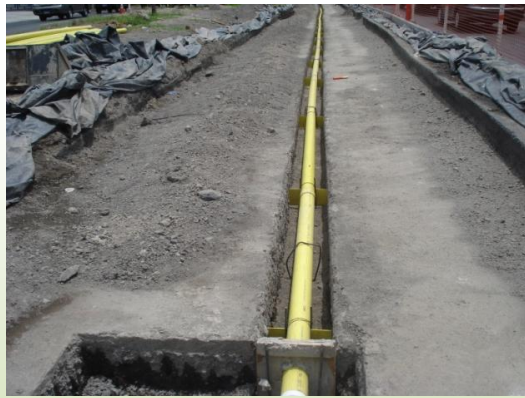
Canalización Fibra Óptica, 23 de Julio de 2013. (Fotos de Funde)
