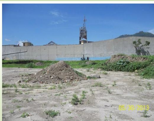
En la segunda visita de campo se observó que el terreno no presentaba ningún cambio de avance. (Foto de FUNDE)
