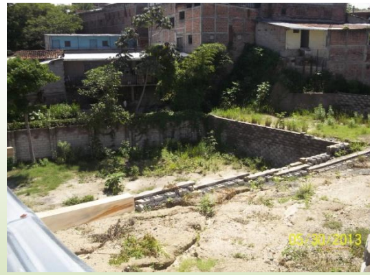
Se han realizado actividades de mantenimiento en bordes de tierra suelta para evitar obstrucción en áreas colindantes al terreno como las comunidades cercanas, aceras y calles. (Foto de FUNDE)
