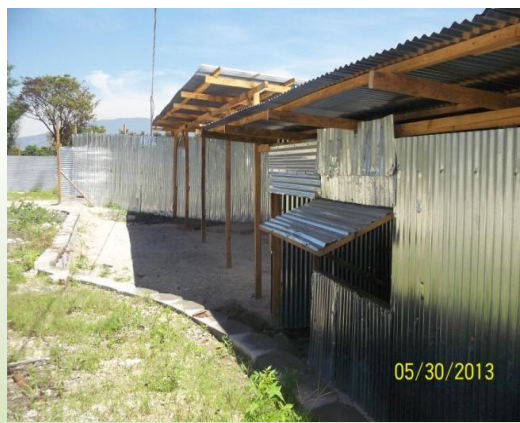
Las instalaciones provisionales del Plantel han recibido mantenimiento, tal como oficinas, bodegas, comedor para el personal, etc. (Foto de FUNDE)
