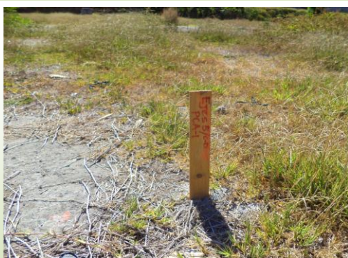
Referencias para los sondeos del subsuelo, indican los pozos a cielo abierto y las coordenadas según los ejes del proyecto. (Foto de FUNDE)
