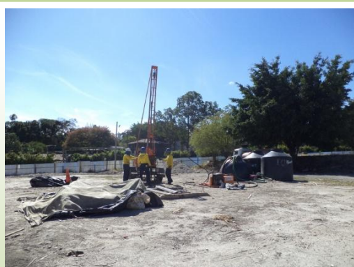
Se están realizando las perforaciones para los pozos a cielo abierto. (Foto de FUNDE)
