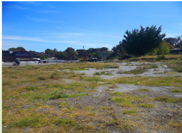
El representante de la supervisora comentó que el suelo contiene cierta cantidad de ripio y que habrá que removerlo. (Foto de FUNDE)
