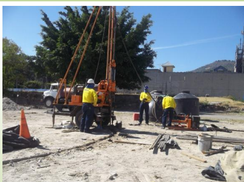
Se observaron actividades para las perforaciones rotativas, lo que permite verificar la capacidad de carga del suelo. (Foto de FUNDE)
