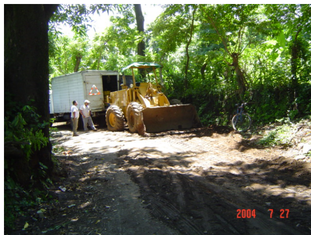
Reparación calle a Cantón La Peña
