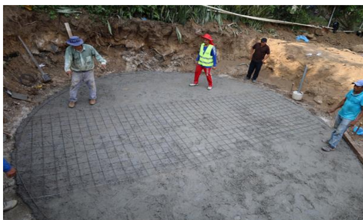
Base de la cisterna, reforzada con estructura de hierro y cemento para prevenir afectaciones sísmicas
