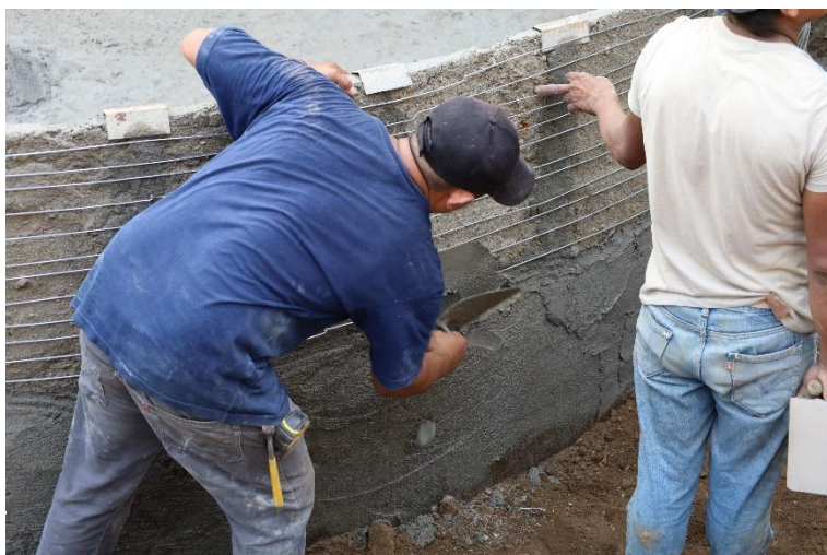
Participantes en el taller avanzan en la construcción del cuerpo de la cisterna
