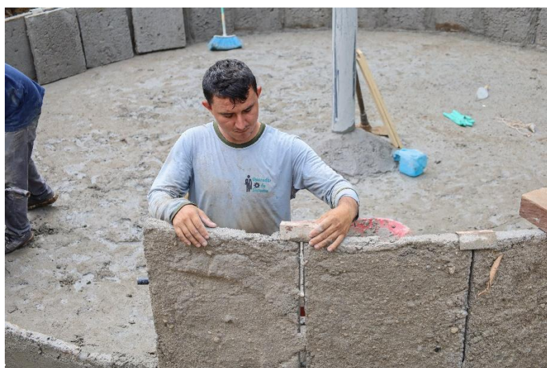
Rafael Soares Moreira, técnico brasileño, muestra la forma para fijar las placas durante el proceso de construcción de la cisterna
