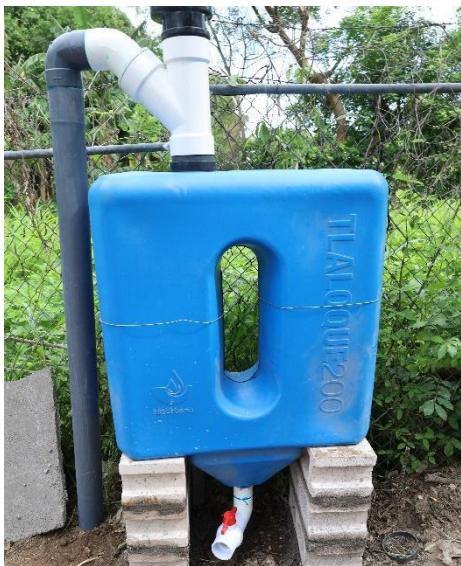
Muestra del tipo de filtro que se colocó a la cisterna
