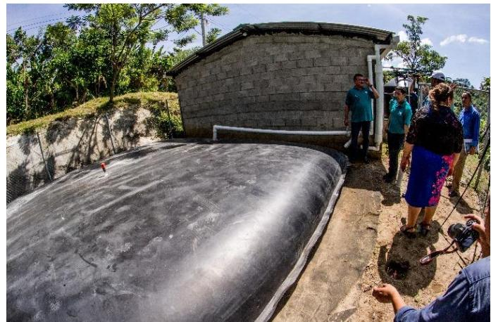
Después de pasar la etapa de filtrado el agua es conducida hacia una bolsa elaborada con una geomembrana de alta densidad de 1 mm de espesor, con protección UV para hacerla resistente a los rayos del sol. La bolsa cuenta con accesorios de entrada y de salida para extraer el agua, también tiene una válvula para purgar el aire dentro de la misma y así permitir que alcance su máxima capacidad.
