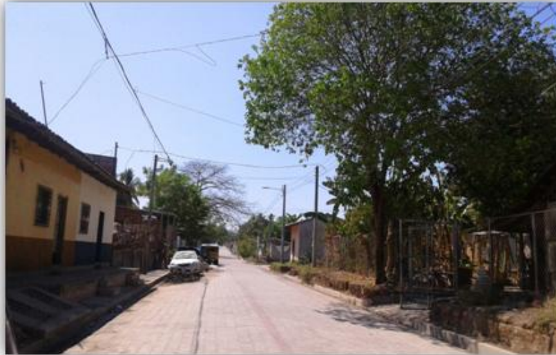
Estado actual del proyecto Adoquinado y Cordón Cuneta Calle Principal de Col. Padre Pio.
