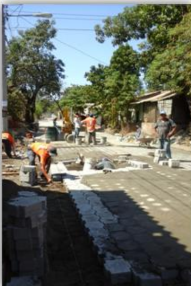
Estado actual del proyecto construcción de Cordón Cuneta y Adoquinado en Calle Los Laureles, Av. Tropical, Av. Principal e Intersección de 4a. Avenida norte Colonia El Palmar.
