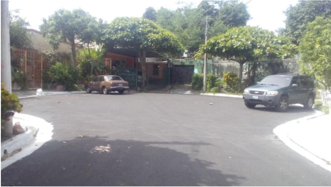
Imagen No. 10. Vista general del proyecto, colocación de Capa asfáltica, longitud aproximada 55 metros.
