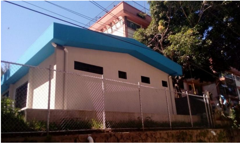
Imagen No. 18. Elevación posterior, se aprecia el cerramiento con malla ciclón.
