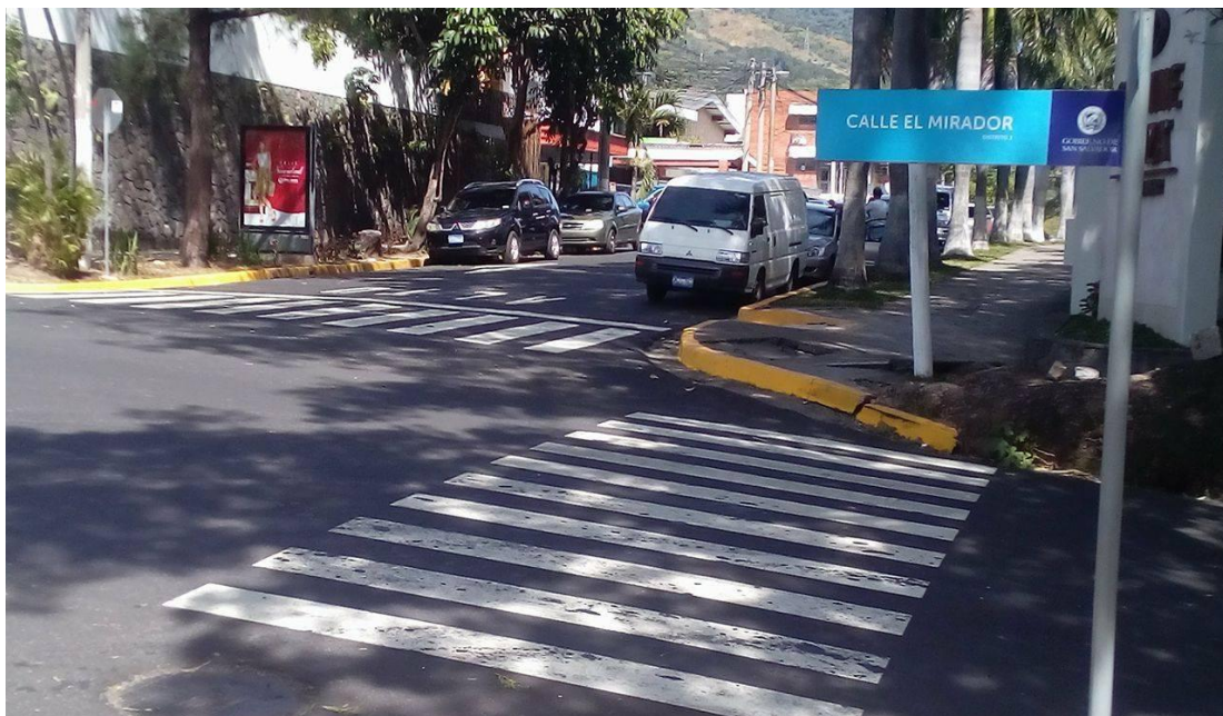
Imagen No. 29. Uno de los lugares más representativos que se intervino es la cruz calle formada por la Calle El Mirador y la 89 Av. Norte ya que en ese cruce se cambió por completo la capa asfáltica 50 mts. de longitud sobre cada calle, en total 200 mts.
