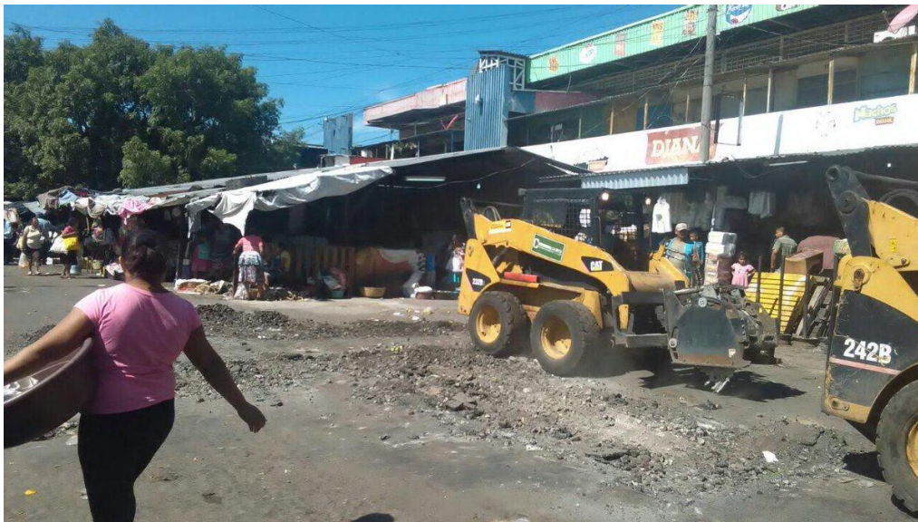
Imagen No. 26. Cercanías del Mercado Central, Distrito 6.
