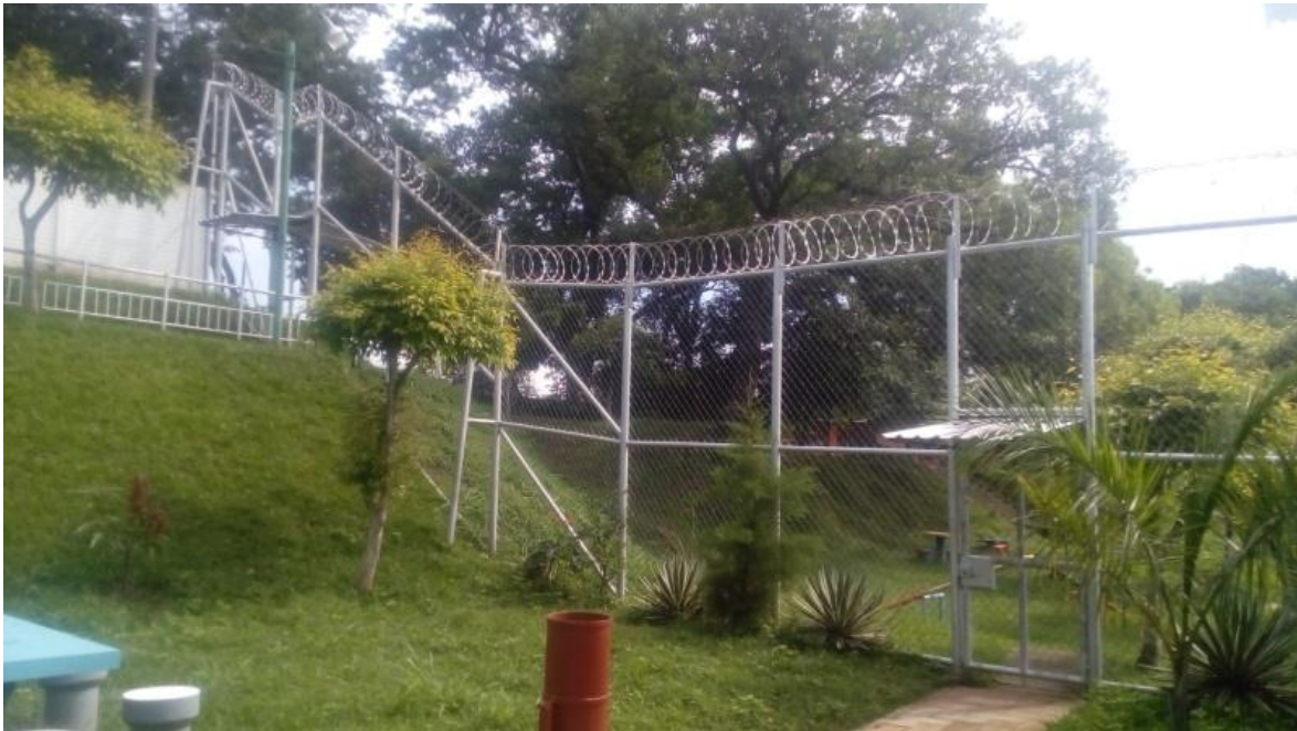
Imagen No.4. Talud y cierre perimetral de Área Verde.
