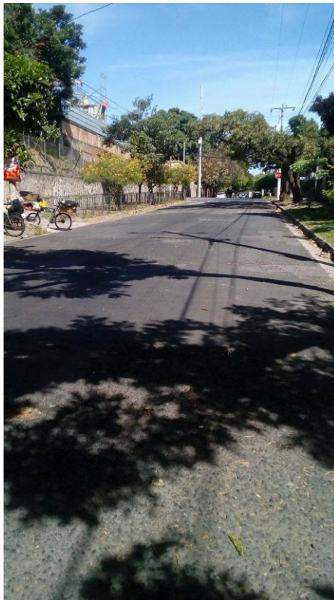
Imagen No. 31. Se observa el trabajo realizado en la 7ª. Calle Poniente.
