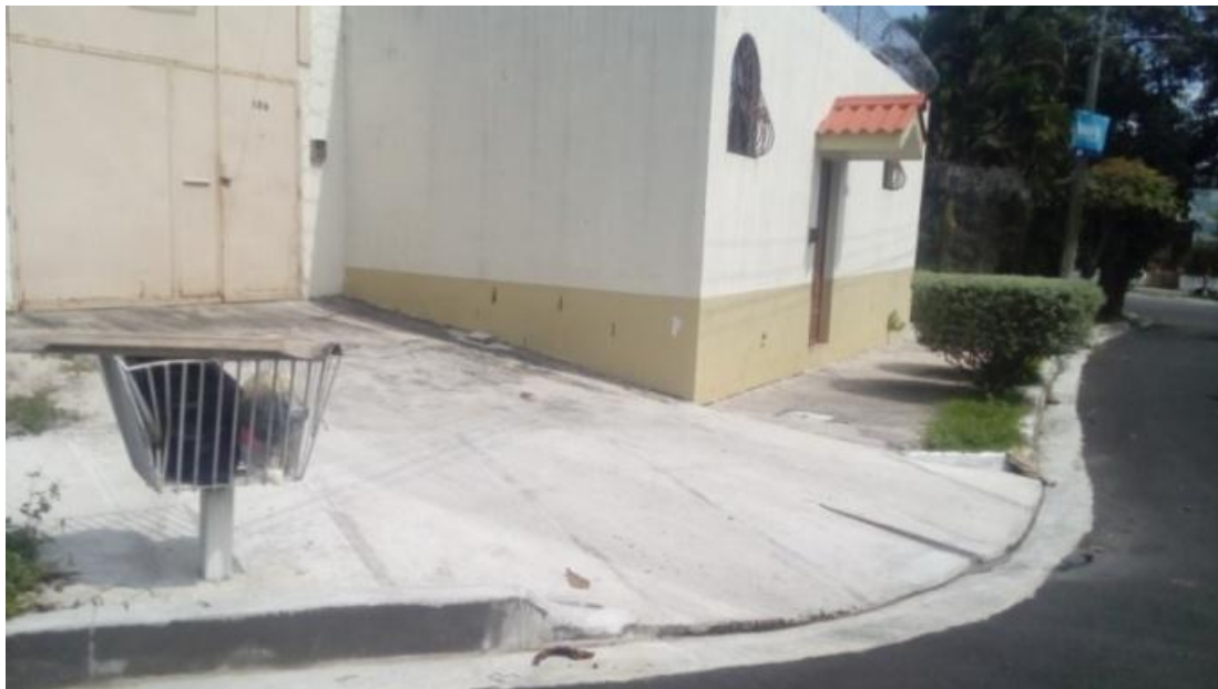
Imagen No. 12. Construcción de rampas vehiculares y aceras.
