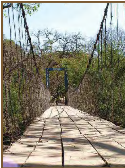
Puente colgante en el paso "ciego" entre San Lorenzo, El Salvador y Jerez, Guatemala.
