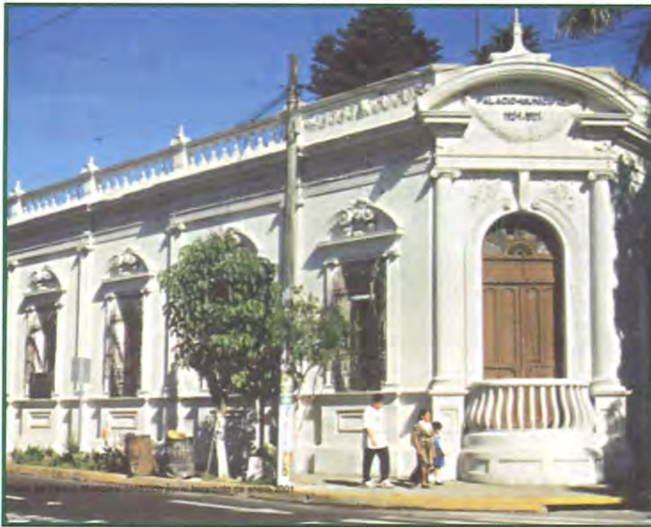
Fachada del Palacio Municipal destruido por el terremoto de enero 2001
