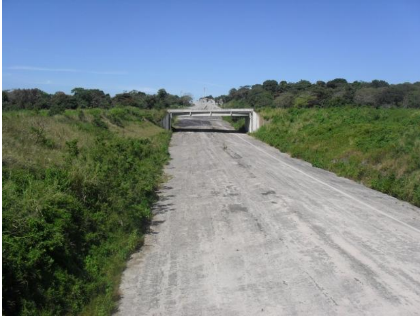
Bulevar Diego de Holguín. Sección 1 del Tramo II.
