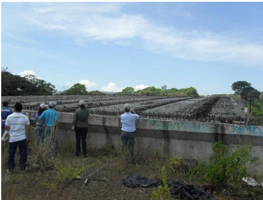
Obra de paso sobre la Avenida Jerusalén
