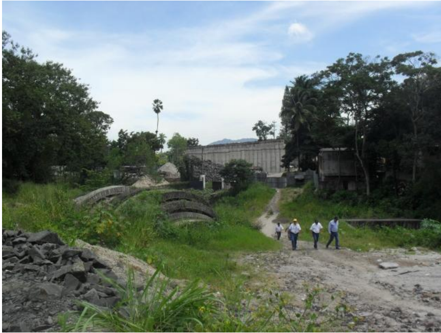
Vista de la sección 3. Al final la obra de paso sobre la avenida Manuel Enrique Araujo
