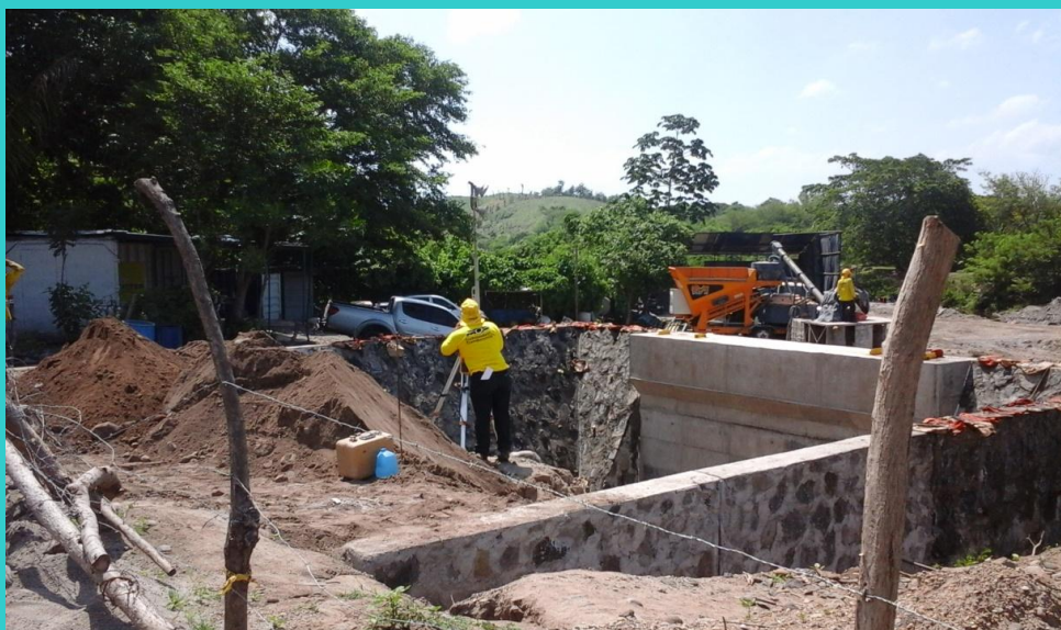
El estribo que intercepta el camino proveniente de los municipios Panchimalco y Rosario de Mora, se encuentra en la fase final de construcción. Foto de Funde.
